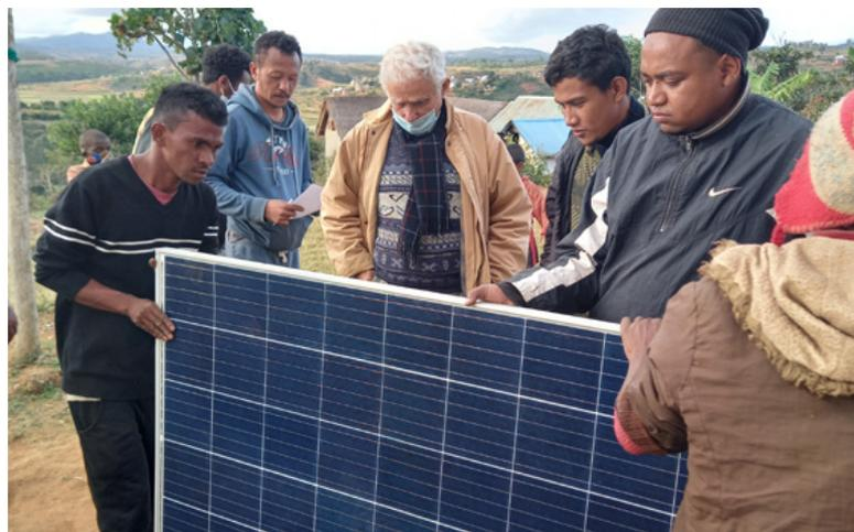
Les premiers travaux se sont concentrés sur le centre de santé, afin de créer toute l'installation électrique. Des barres pouvant recevoir les panneaux photovoltaïques ont été posées. La mise en place des panneaux a été plutôt simple, puis toute l'installation intérieure a été réalisée afin de mettre dans la salle de soins et de repos un peu de lumière.
